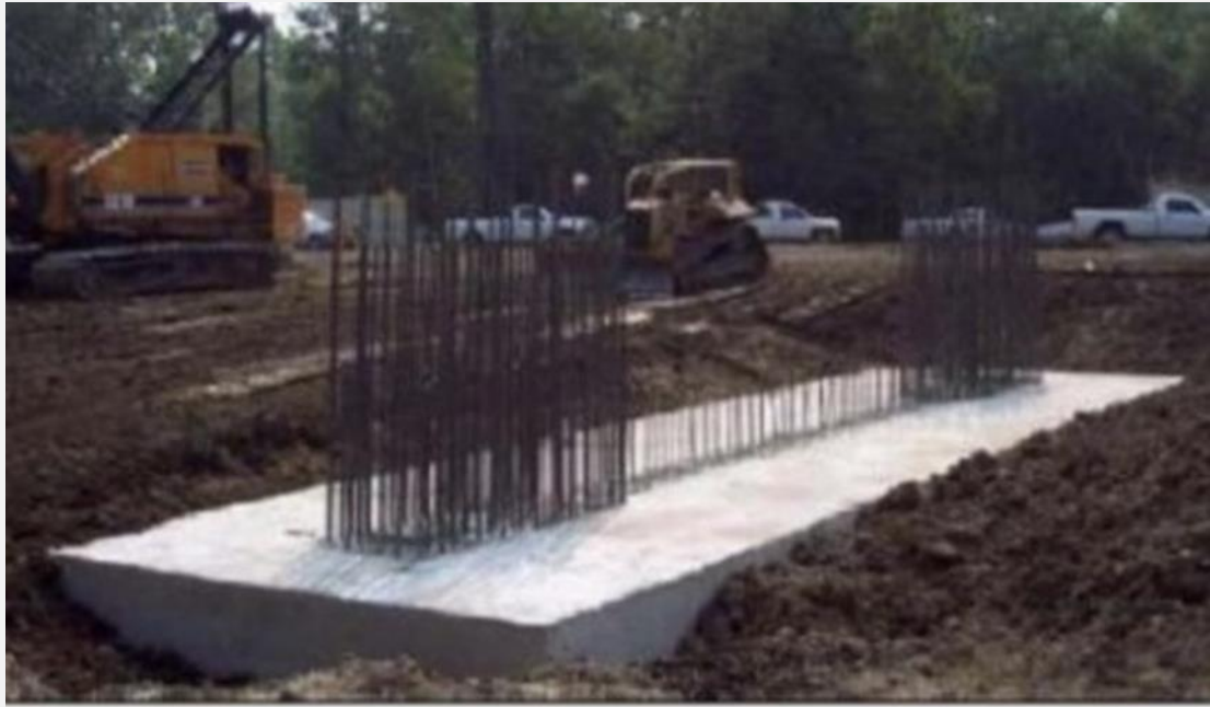
(۱۲) فونداسیون کلاف شده
